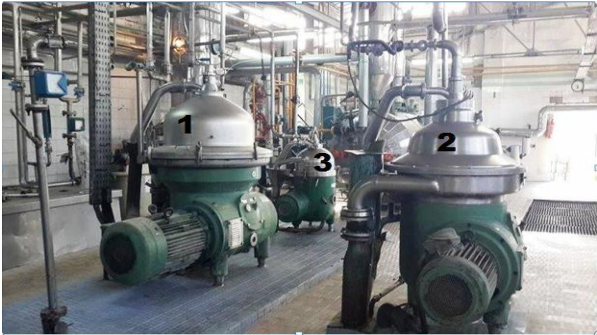
Figure 6: séparateurs RSA 60 (2) et RTA (3)
