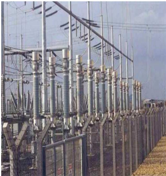
**Figure 7 : Combiné de mesure (TT-TC)**
