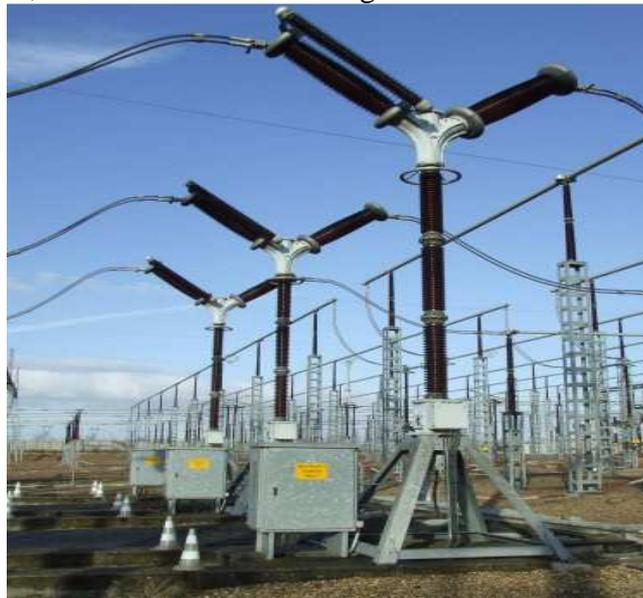
**Figure3 :Disjoncteur dans un poste électrique**
