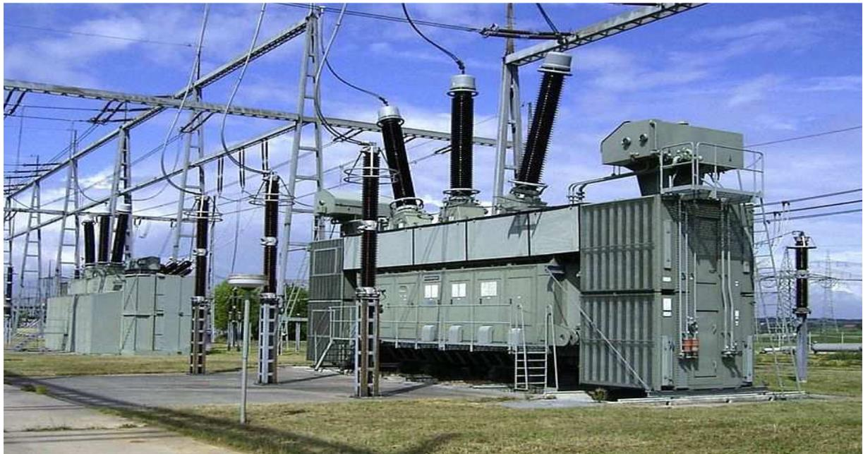
**Figure2 : Transformateur de puissance**
