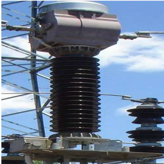
**Figure6 : Transformateur de courant**
