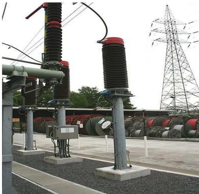
**Figure5 : Transformateur de tension TT**
