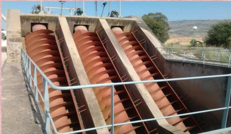
Photo 2 : Opération de relevage dans la station de prétraitement
