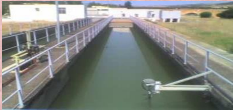
Photo5 : Opération de décantation dans la station de traitement
