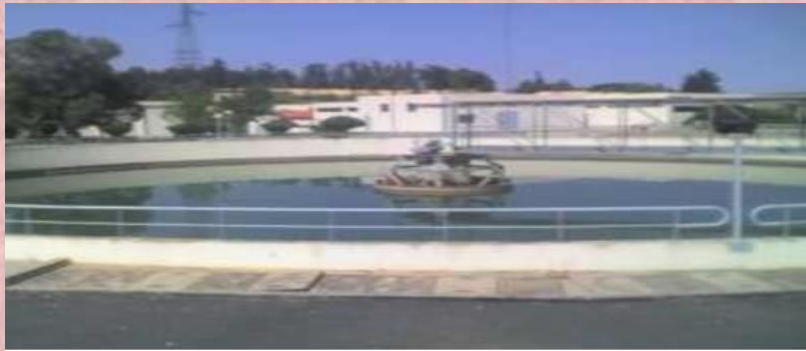
Photo4 : Opération de débouage dans la station de prétraitement.
