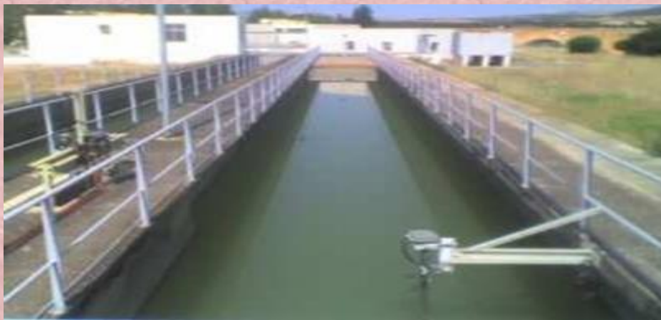
Photo3 : Opération de dessablage dans la station de prétraitement.
