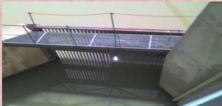
Photo1 : Opération de dégrillage dans la station de prétraitement.
