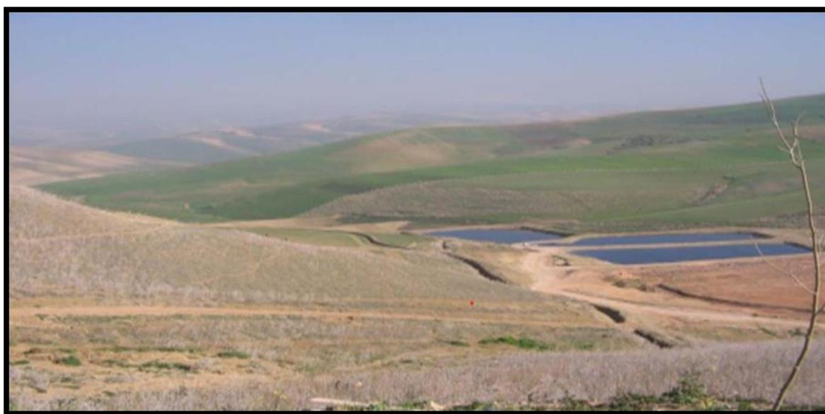
**Figure 1** : Bassins de stockage des lixiviats de la décharge contrôlée de Fès
