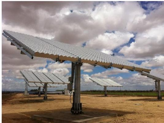
**Figure III.2 : Le système HCPV BSQ-D280/53**
