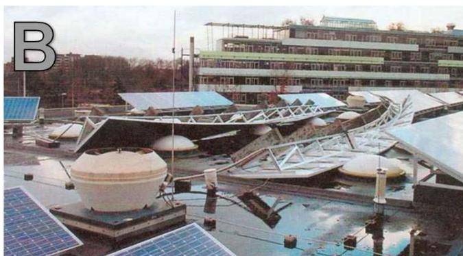
Figure I.10 : Structure PV arrachée par le vent.
