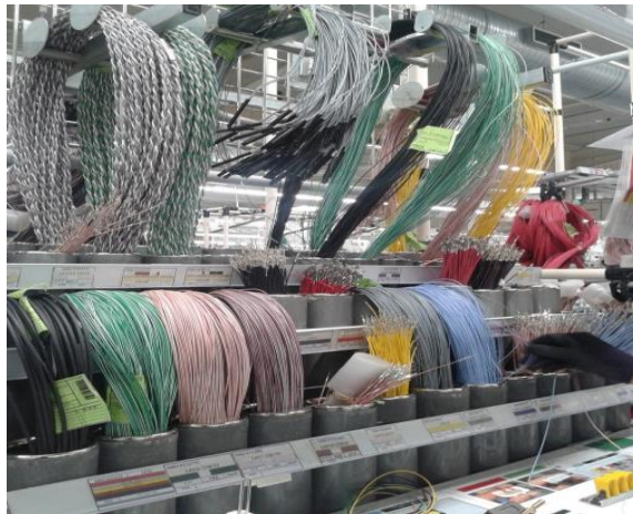
Figure 47 : Joints montés sur des tobos
