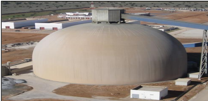
Figure 7:Dôme de stockage de clinker
