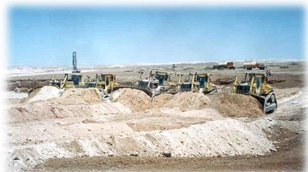
**Figure 8 : opération de décapage par bulls**
