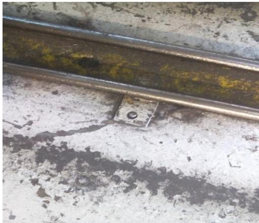
Figure38 : desserrage des écrous
