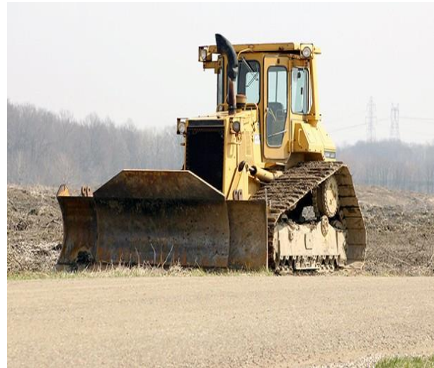
Figure 7: décapage par bulls
