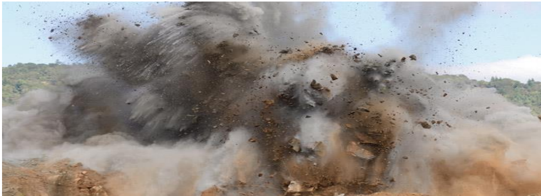
Figure 5: opération de sautage
