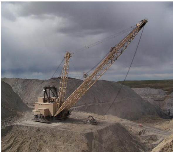
Figure 6: décapage par dragline
