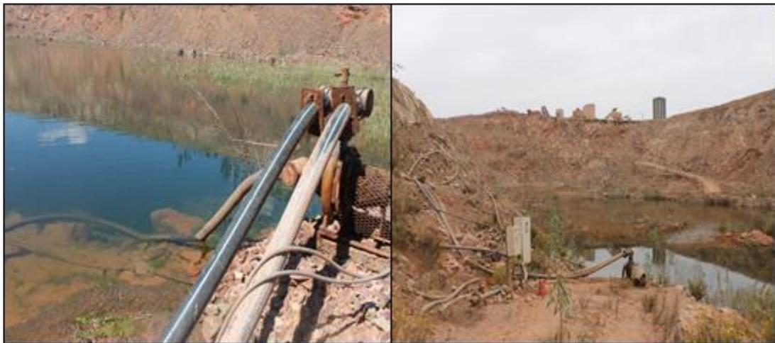
Figure 15: Les unités de pompages installées dans les affleurements de la nappe.
