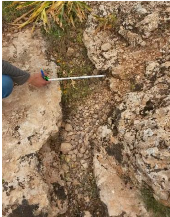
Figure 10 : fracture ouverte dans le site d'A. Bouchermou.
