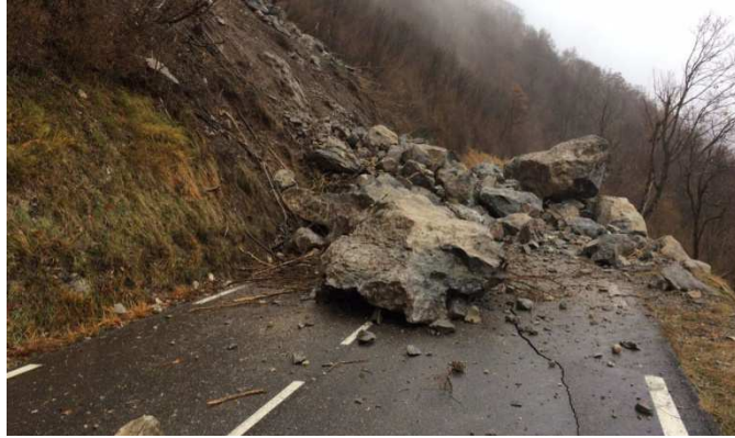
Figure 8 : Chutes de blocs et de pierres
