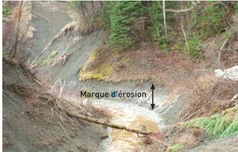
Figure 5 . Marque d'érosion à la base d'un talus
