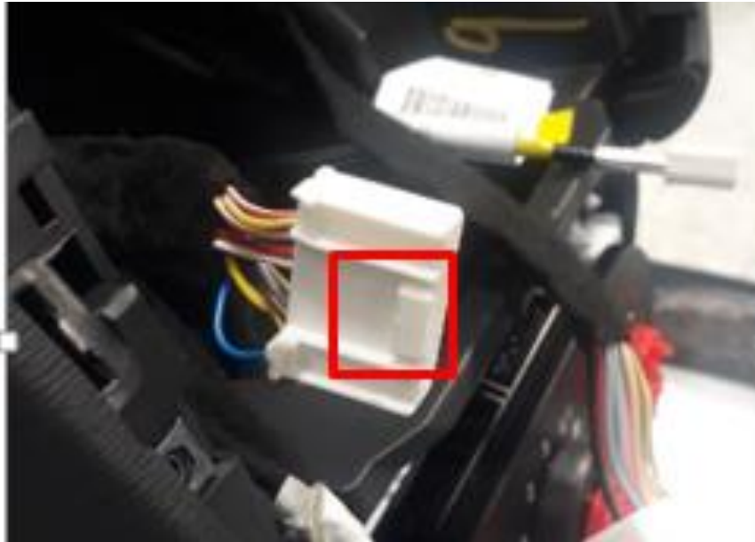
Figure 6 Exemple d'un connecteur cassé (verrouillage cassé)
