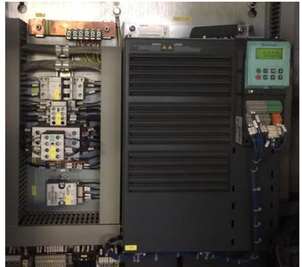
Figure 29 : Variateur de vitesse du moteur de levage, Table 62
