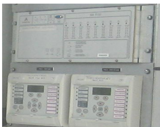
Fig. 13 : Relais ampérométrique type numérique
