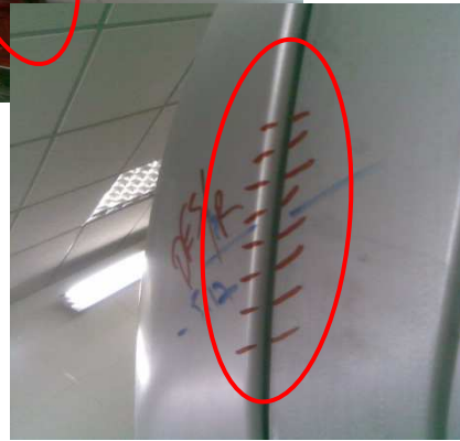
Figure 7 : désaffleurement porte façade AR
