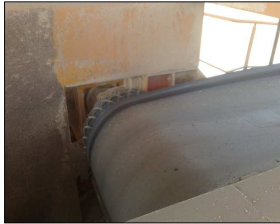
Figure 2 : Convoyeur de mise en vitesse. Carrière HAZEMAG
