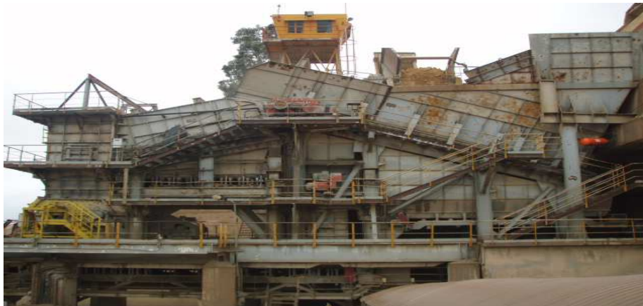
Figure 2: Vue globale du concasseur HAZEMAG
