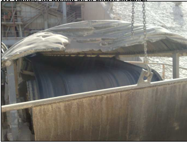
Figure 1 : Convoyeur sortie concasseur. Carrière HAZEMAG
