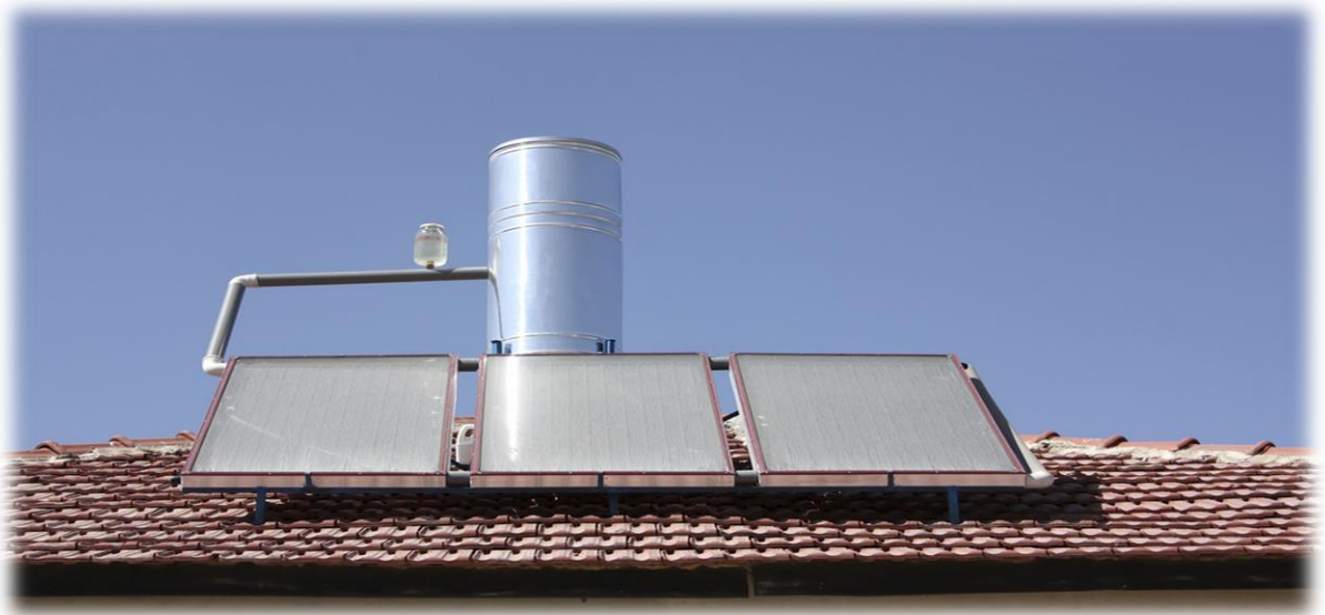
Figure 4 : Chauffe-eau solaire auto vidange
