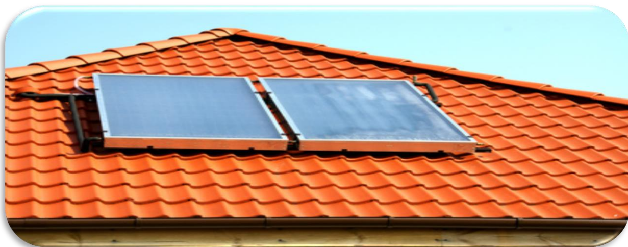
Figure 5 : Chauffe-eau solaire à circulation forcée
