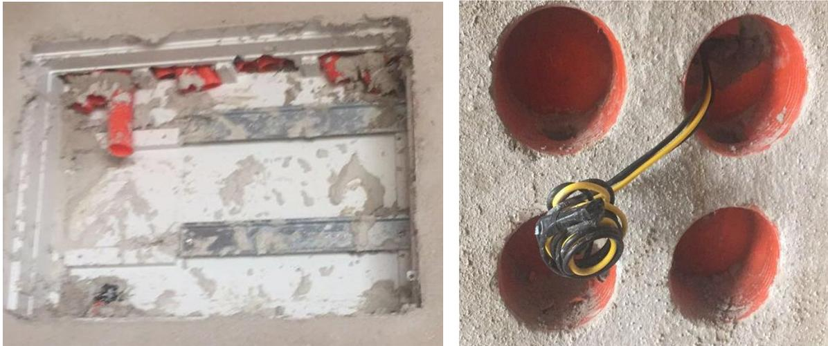
Figure 8 : Les tubes et le tirage des câbles
