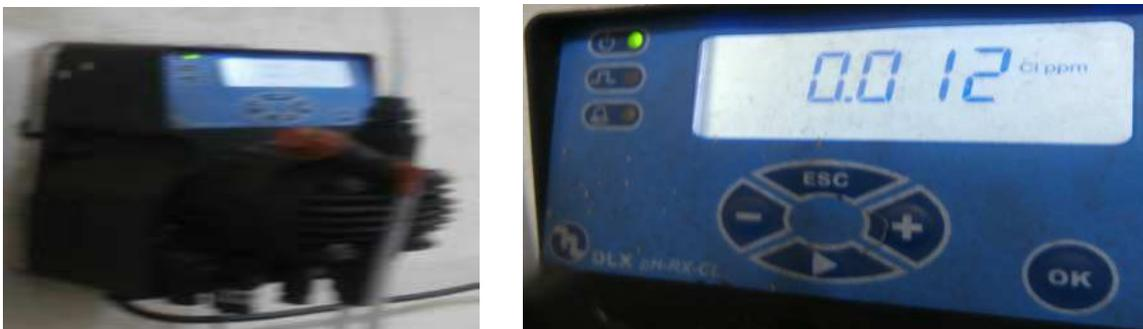
**Figure 38:** Pompe doseuse électromagnétique à montage mural avec régulateur intégré de chlore.
