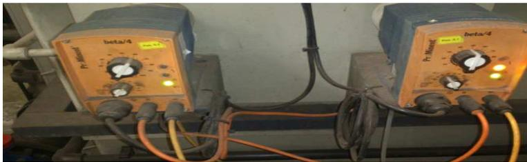
**Figure 41:** Pompe doseuse à membrane bêta
