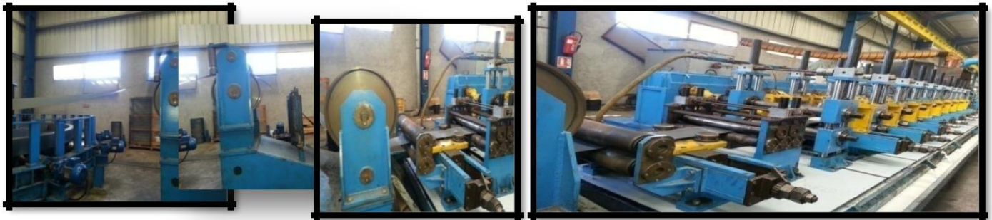
Figure 8: Feuillard guidé vers le premier bloc de formage/Insertion du feuillard
