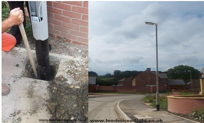
Figure 17 : Méthode d'enfoncement
