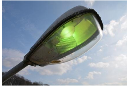
Figure 23 : lampe à vapeur de mercure
