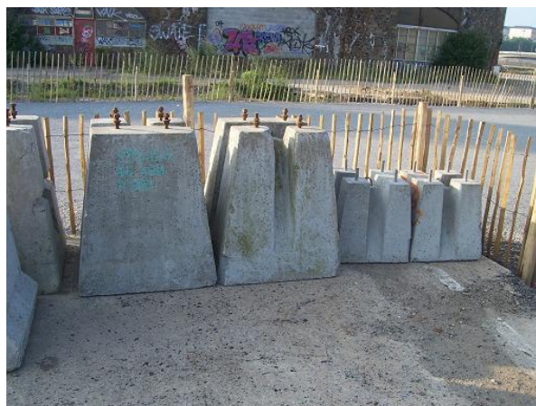
Figure 18 : Méthode semelle de fixation
