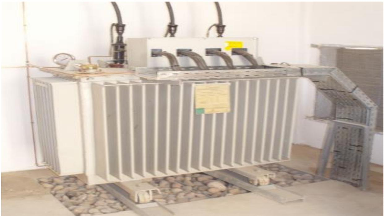
FIGURE 3: Transformateur de puissance
