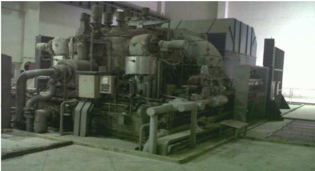
**Image 3.3 :Groupe turbo alternateur de central thermique**
