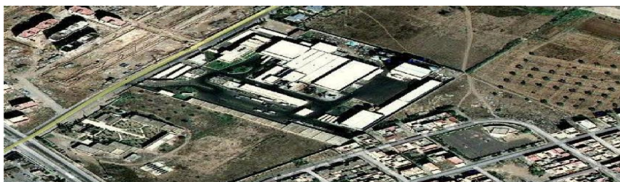
Figure 1 : Photo aérienne de la COLAIMO
