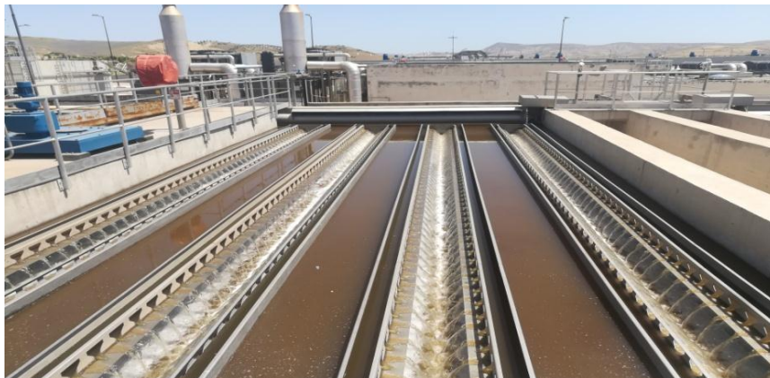
Figure 5 : Décanteur lamellaire
