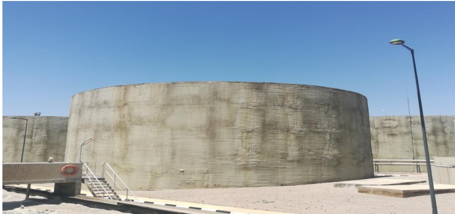
Figure 12 : Digesteur
