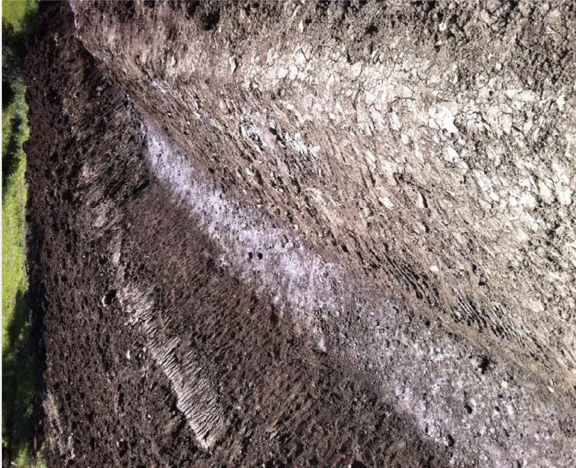
Les déblais en grande masse seront extraits à l'aide de la pelle pour être mis en remblais ou en dépôt s'ils sont excédentaires ou impropres.
