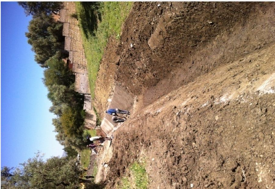
Opérations de **bétonnage** : Le béton de propreté b5 est coulé sur place à l'aide d'une bétonnière.
