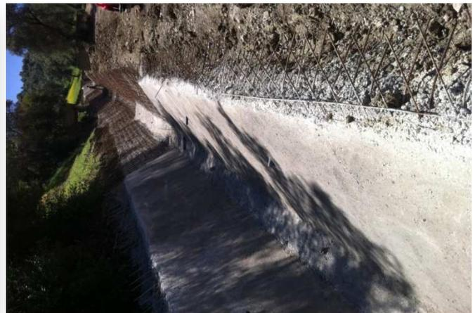
Opérations de **bétonnage** : Le béton armé b2 est coulé sur place à l'aide d'une bétonnière.
