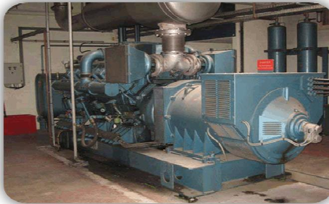
*Figure 9 : le groupe électrogène (10Kv ; 1250KVA)*
