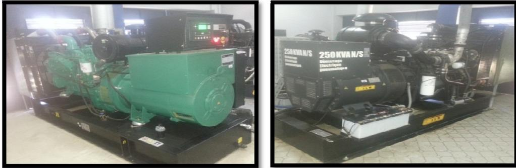
*Figure 4 : Groupes électrogènes 250KVA*
