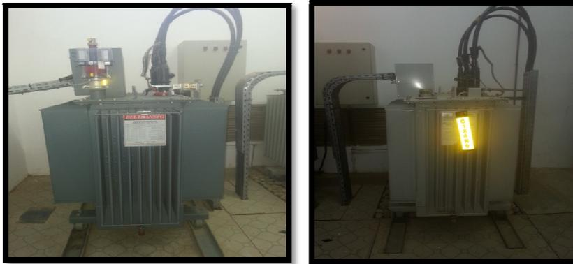
*Figure 3 : Transformateurs triphasés abaisseurs 22KV-380V*
