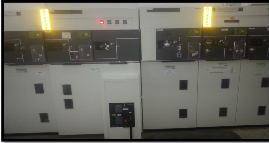
*Figure 2 : Cellules d'arrivée de l'ONE 22KV*
