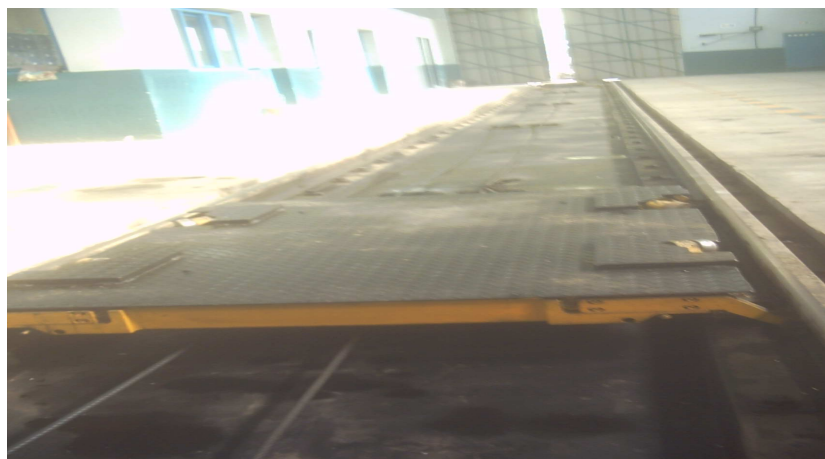
Figure 9 : Le système de manœuvre
