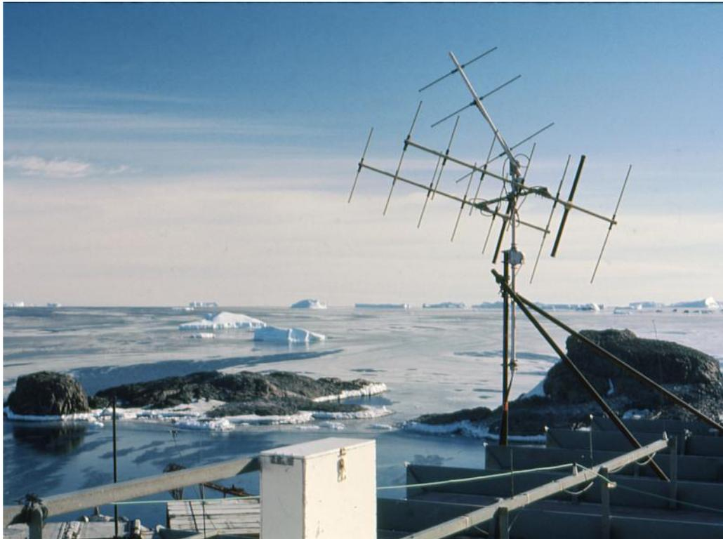
Figure 3 : antenne orientable pour trafic satellite
