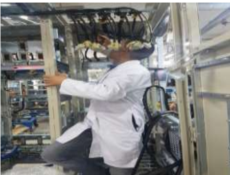
Figure 25: intégration dans l'armoire LVC
