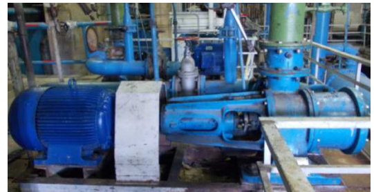
Figure 7 : Image réelle de la pompe à vide
