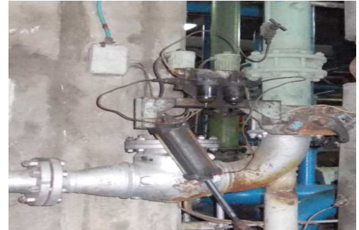
Figure 6 : Image réelle de l'éjecteur
