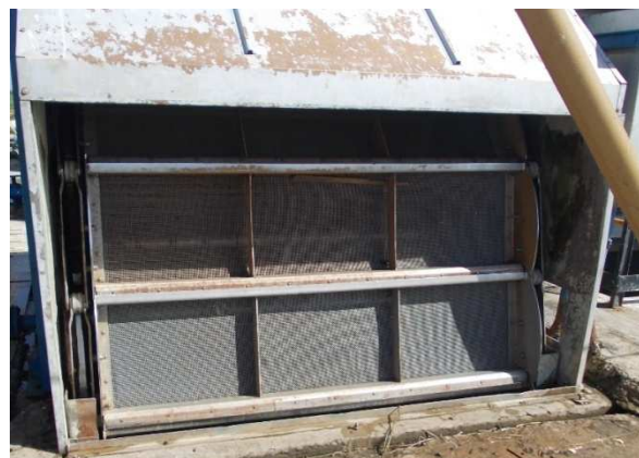
Figure 19: Image réelle de la grille tournante
