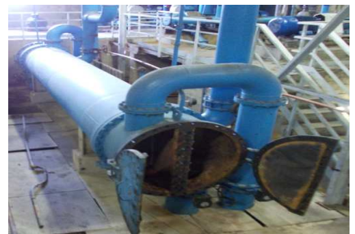
Figure 22 : Image réelle du réfrigérant NORIA
