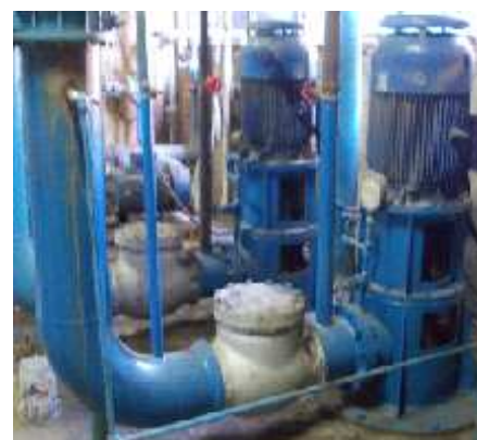
Figure 23 : Image réelle de la pompe NORIA
