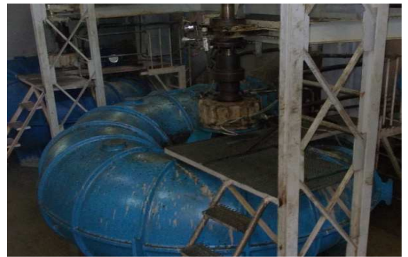
Figure 21 : Image réelle de la pompe de circulation
