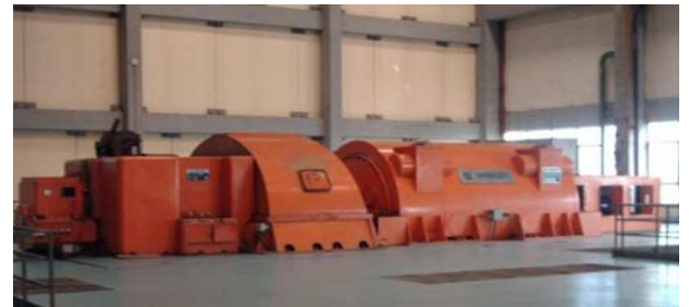
Figure 25 : Image réelle de l'alternateur
