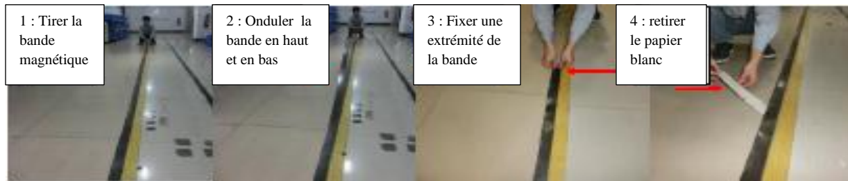
Figure 29: Procédure de fixation du Tape
