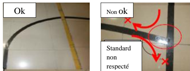
Figure 30 : Vérification du standard lors du traçage
