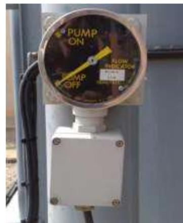
*Figure 9: Détecteur d'arrêt pompe*
