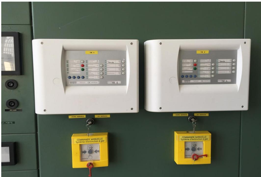
Figure 11: centrale de détection et d'extinction
