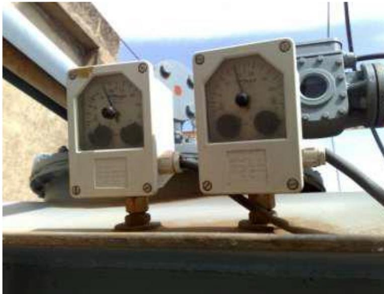
*Figure 7: Dispositif de détection de température*
