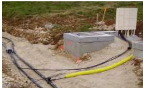
*Figure 3: Représentation d'un réseau souterrain*
