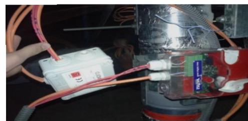
FIGURE 3.10 -MDLO RACCORDE AVEC UN CLAPET COUPE-FEU.
