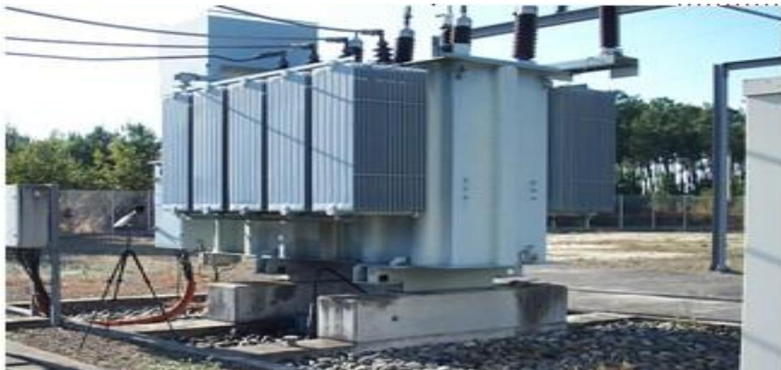
**Figure 6 : Prise de vue du poste source douiyat .Transformateur de puissance**
