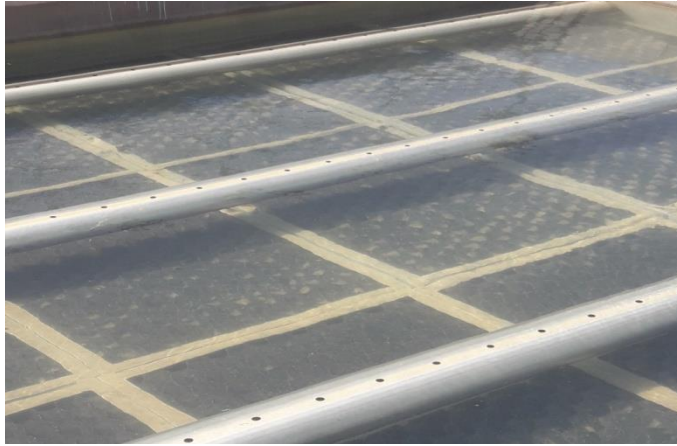
Figure 13 : Décanteur Lamellaire
