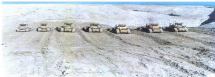
Figure 11: Décapage par Bulldozer.
