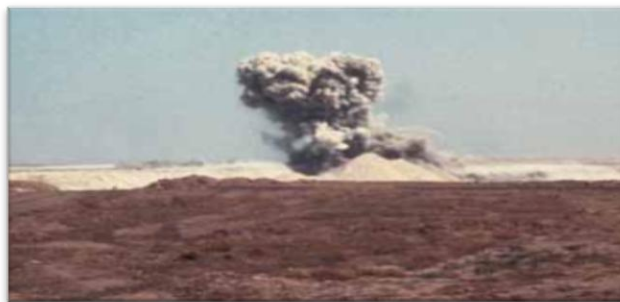
Figure 10: Opération de sautage.
