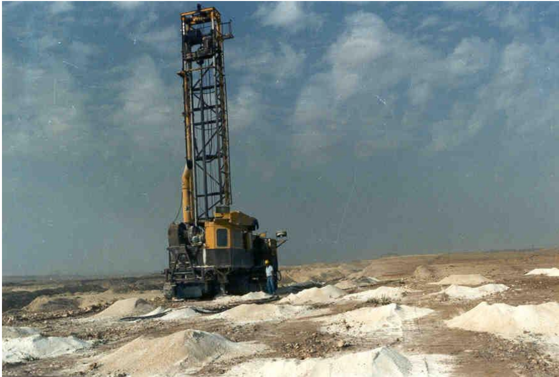
Figure 13: Opération de foration par une sondeuse sk5
