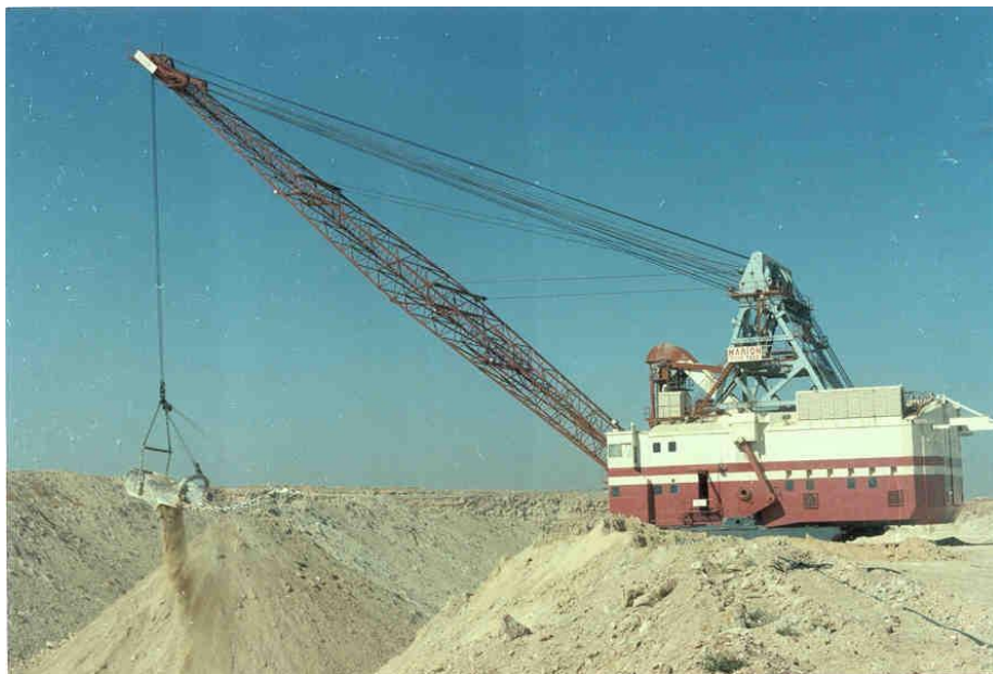
Figure 15 : Opération de décapage par dragline 8400
