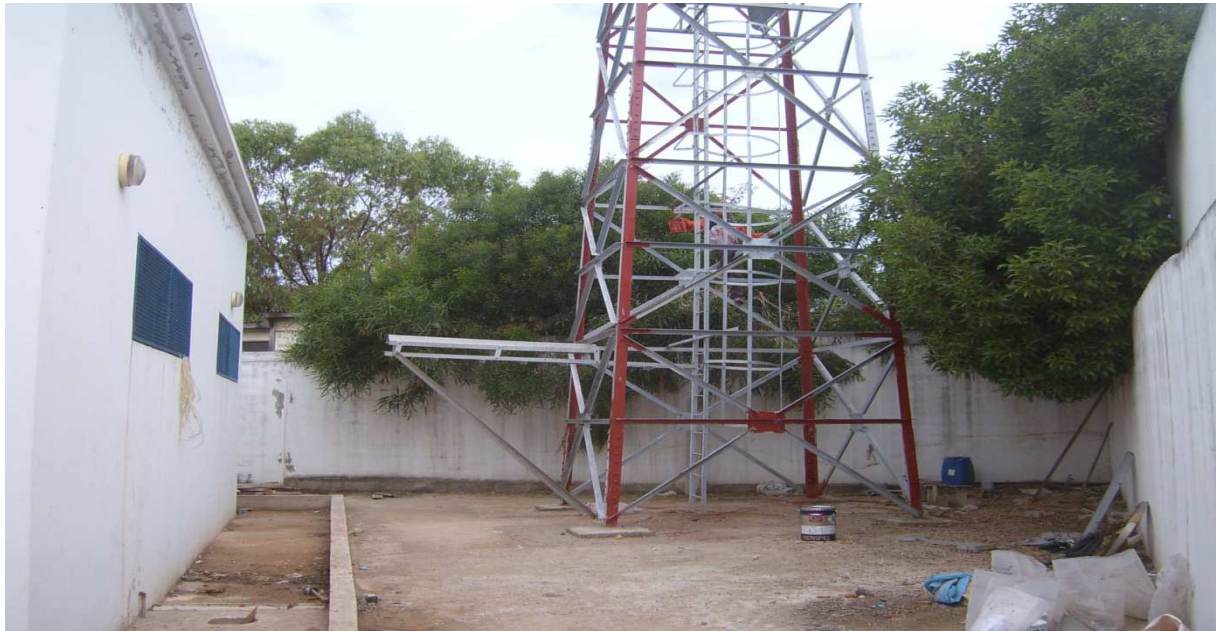
Montage pylône achevé et peinture en-cours (le montage pylône prend 6 jours, la peinture 1 journée et demi)
