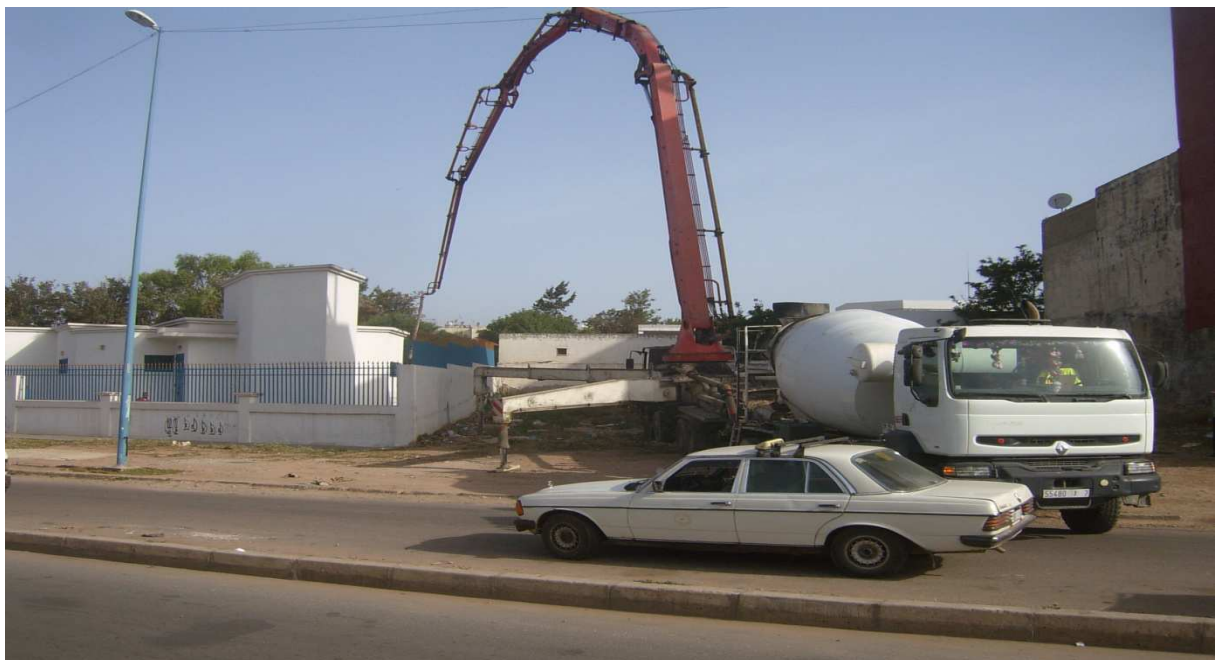
Coulage du béton (le coulage du béton se fait en 2 heures le durcissement prend 4 jours après ça suit le remblayage et le montage pylône)
