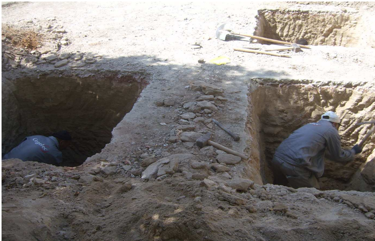
Fouilles en-cours ou (excavation en-cours) la profondeur est définie par les plans de fondation validés par BE
