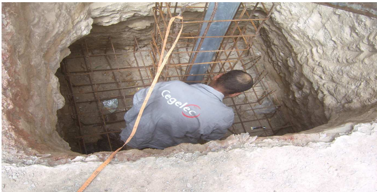
Pose ferrailage et réglage des embases pylônes par gabarit (la confection du ferrailage prend 2 jours de travail et se fait en parallèle avec les fouilles la pose et le réglage des embases prennent 1 demi journée)
