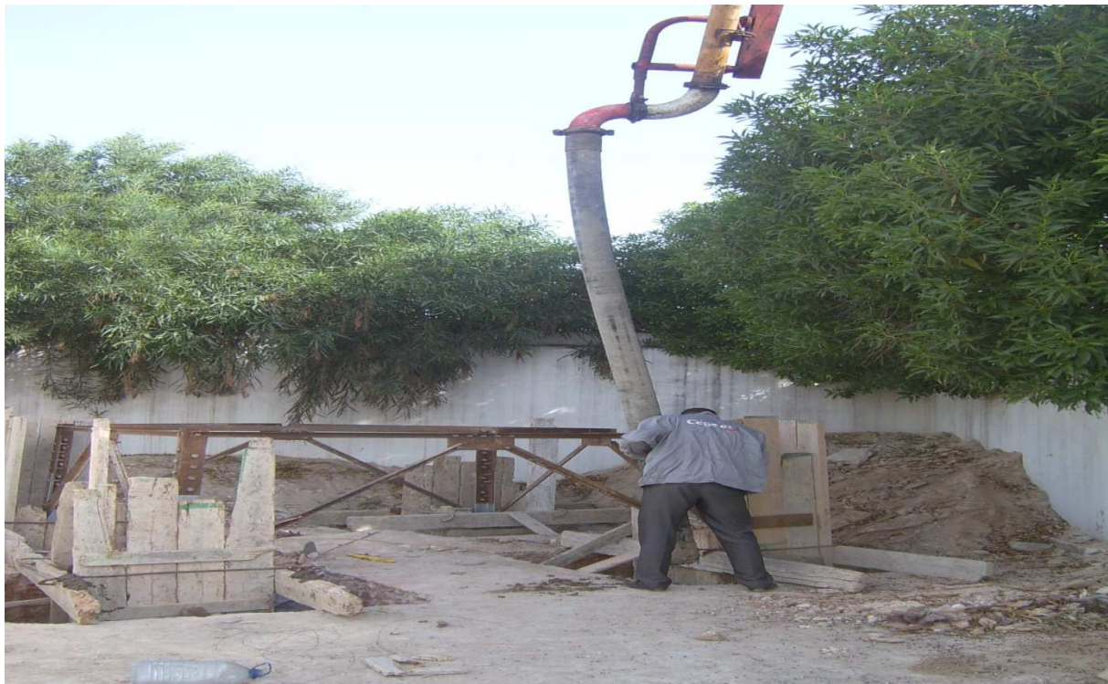
Coulage du béton dosé à 350\text{Kg}/\text{M}^3 (utilisation des coffrages en bois)
