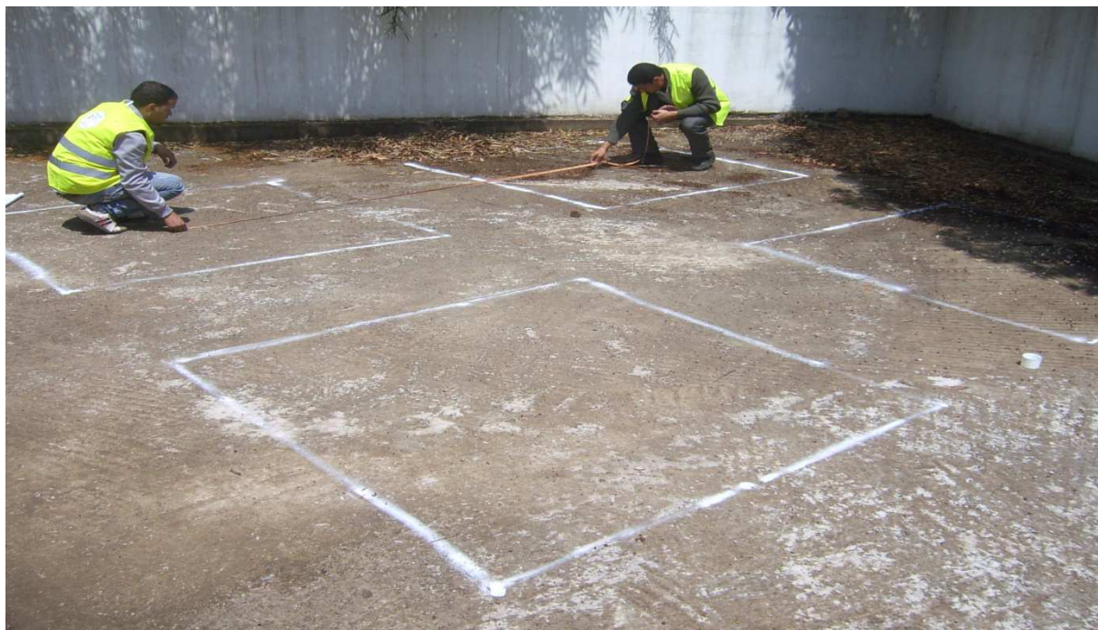
Traçage des fouilles selon les plans validés par Bureau d'étude
