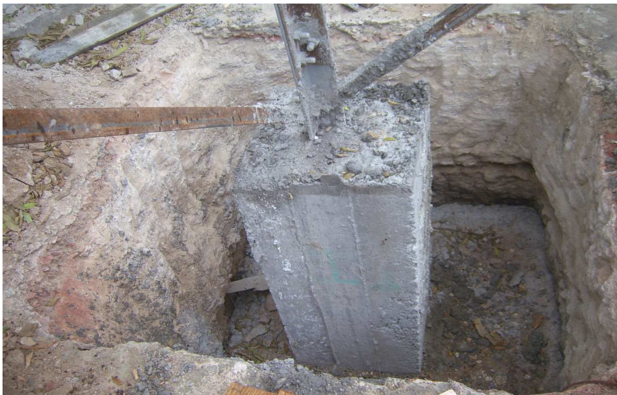
Fin de coulage et décoffrage (enlèvement coffrages en bois)
