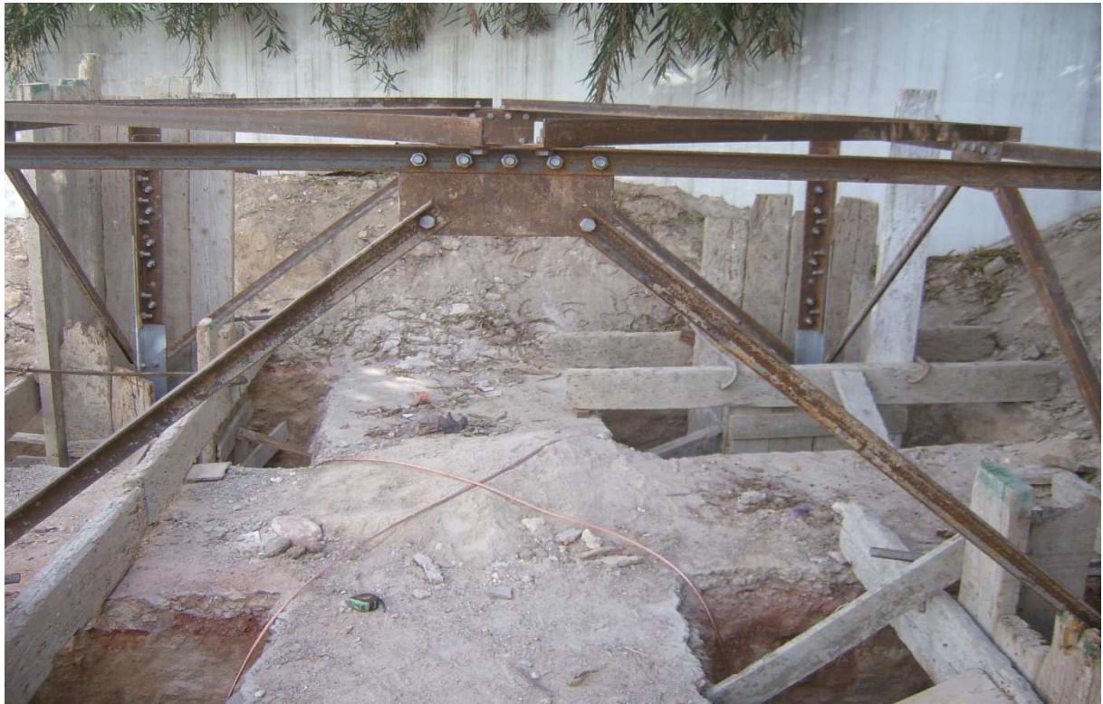
Gabarit en place prêt pour coulage béton dosé à 350\text{Kg}/\text{M}^3 (le gabarit c'est la partie non galvanisé de la structure sur photo)
