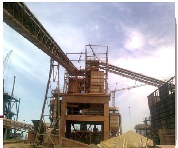
mélange des matières premières sont prélevés lors de la constitution des tas dans une station d'échantillonnage, ces échantillons sont analysés au niveau du laboratoire de l'usine. Les résultats de ces analyses permettent de définir les corrections nécessaires à apporter au mélange des matières premières, ce mélange est dénommé en cimenterie par le crû.
