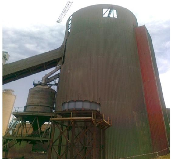
**Figure 15: Silo clinker plus trémie des incuits**
