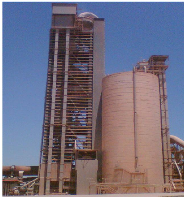
**Figure 11: Silo farine et la tour de préchauffage****\* Four rotatif**
