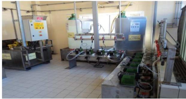
Figure 15 : station d'ajustement des produits d'addition
