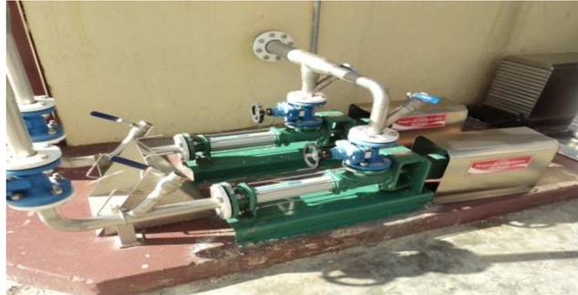
Figure 12 : pompes d'extraction des boues
