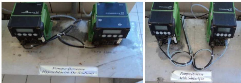
Figure 16 : Pompes doseuses d'hypochlorite de sodium à gauche et d'acide sulfurique à droite
