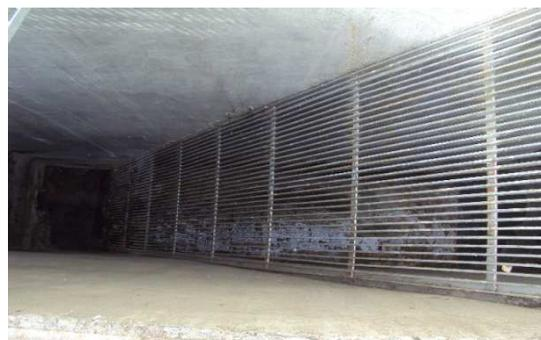
Figure 2 : dégrilleur grossier de la STEP de la CBGN
