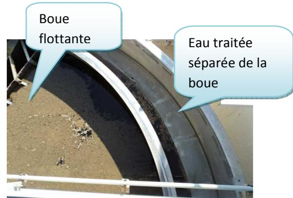
Figure 9 : à gauche le flottateur à droite la séparation de l'eau traitée des boues
