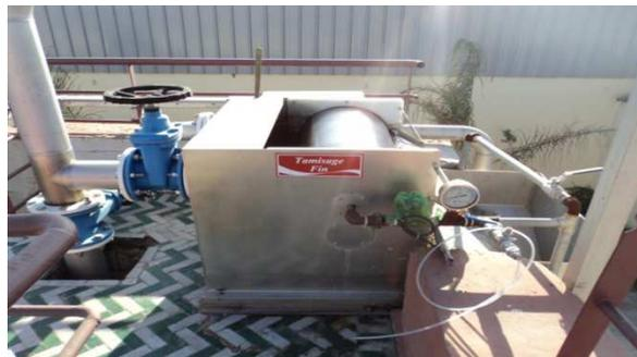
Figure 4 : tamis fin de la STEP de la CBGN
