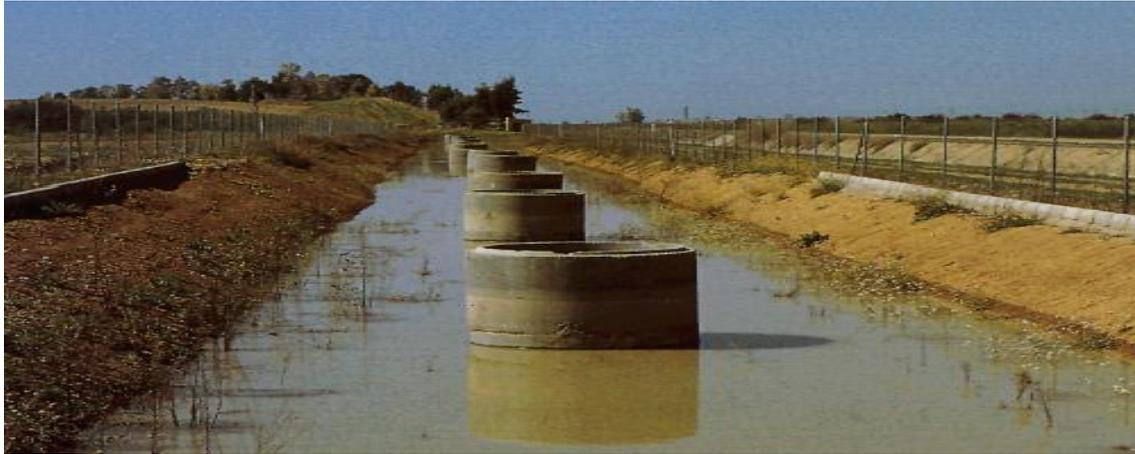
**Figure 23: Dispositif de recharge artificielle par puits d'injection (ABHS)**
