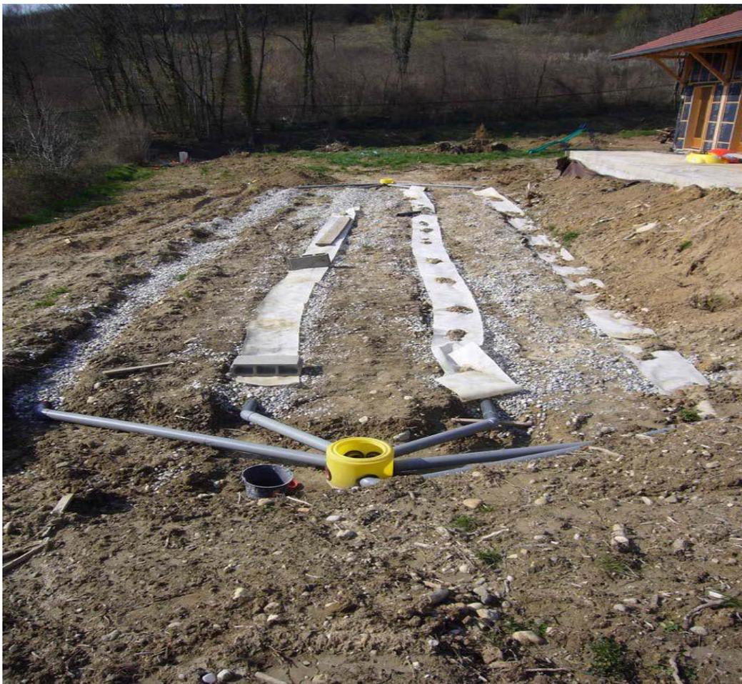
**Figure 35: Tranchées d'épandage parallèles à la pente**
