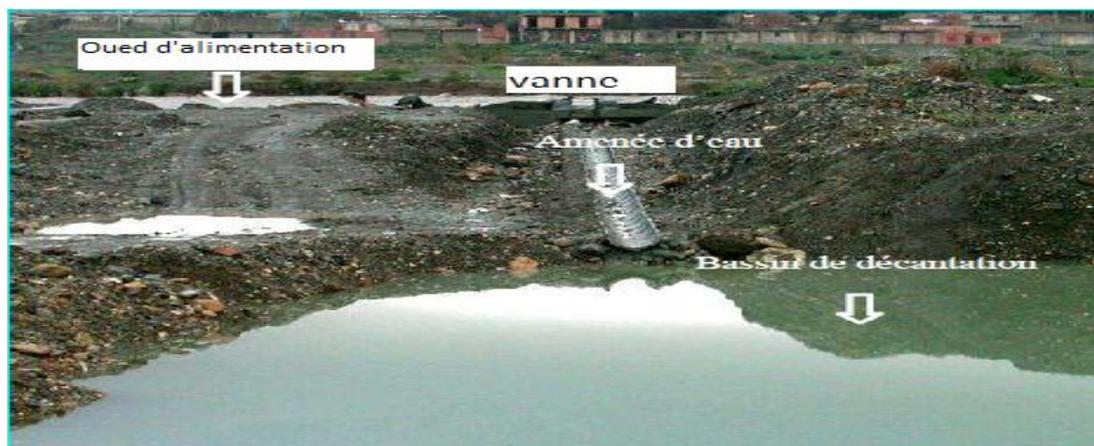
**Figure 20: Les différents dispositifs de RA par injection superficielle**
