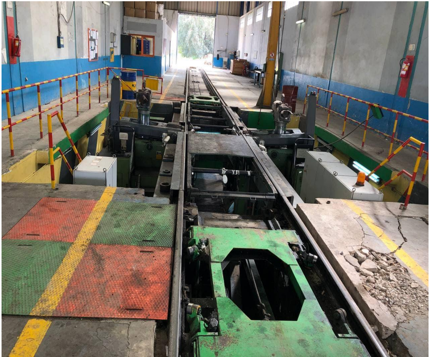
Figure 10: Atelier du tour en fosse.
