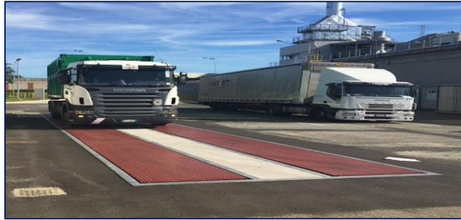
Figure 3: Pont bascule encastré dans le sol
