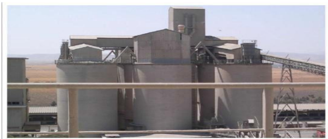
Figure 11 : Silos de stockage de différentes qualités de ciment et le clinker de l'export.
