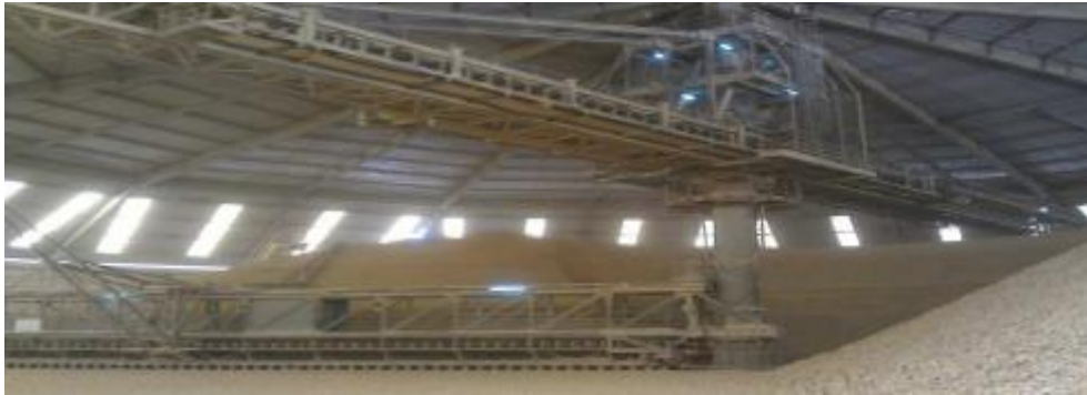
Figure 6: Hall de pré-homogénéisation
